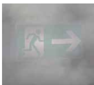
Sinalização de saída mal iluminada
