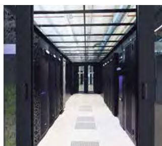
LCS 3 Corredores de contenção térmica (p. 714)
