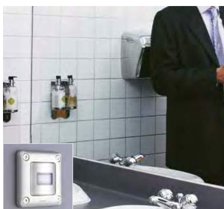
SANITÁRIO PÚBLICO | Detetor de movimentos
