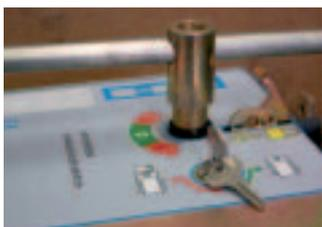
Existe um punho universal para operar manualmente em caso de alguma emergência, adaptável qualquer tipo de painel.
